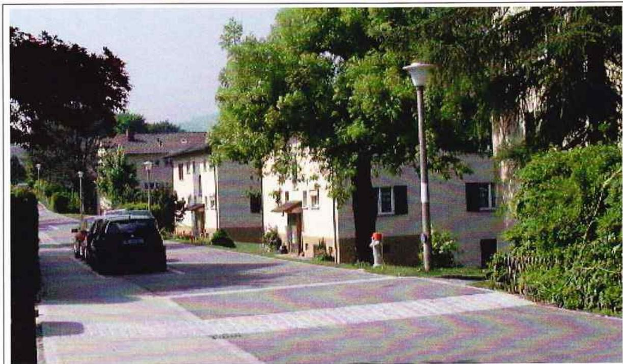
Abb. 3: Horizontaler Versatz im Hintergrund (Parkfelder) und vertikaler Versatz im Vordergrund
